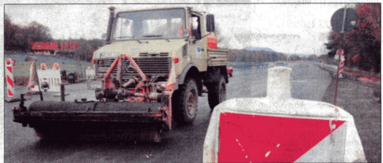
Ist der Asphalt ausgekühlt, kommt der große Besen. Vorarbeiter Erwin Klein auf dem Unimog bereitet die Straße damit für die Markierungsarbeiten vor.
